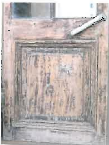
Εικόνες 23, 24. Απομάκρυνση του βερνικιού και εκδορές στην επιφάνεια από την χρήση λειαντικών φύλλων.
