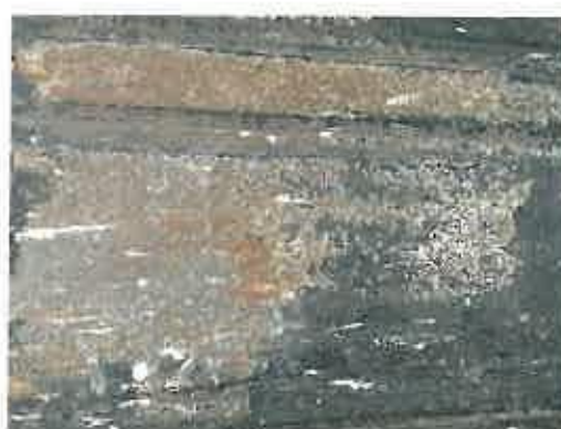
Εικόνες 63, 64. Επιφανειακή οξείδωση
