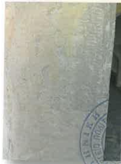
Εικόνα 109. Επικάλυψη του λίθου με κονίαμα
