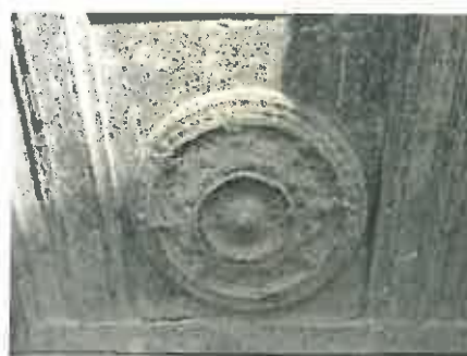
Εικόνες 61, 62. Επικαθίσεις χρώματος και κονιαμάτων
