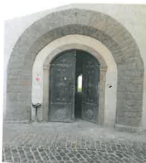
Εικόνα 98. Η κεντρική αψίδα του ισογείου όπου διακρίνονται τόσο το υπόστρωμα, όσο και οι αλλεπάλληλες χρωματικές επικαλύψεις. Εικόνα 99. Η κεντρική είσοδος στην οποία φαίνονται τα δύο διαφορετικά είδη πετρώματος.
