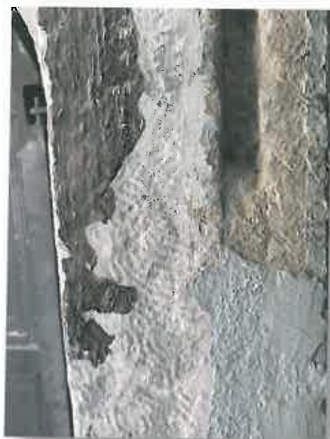
Εικόνα 98. Η κεντρική αψίδα του ισογείου όπου διακρίνονται τόσο το υπόστρωμα, όσο και οι αλλεπάλληλες χρωματικές επικαλύψεις. Εικόνα 99. Η κεντρική είσοδος στην οποία φαίνονται τα δύο διαφορετικά είδη πετρώματος.
