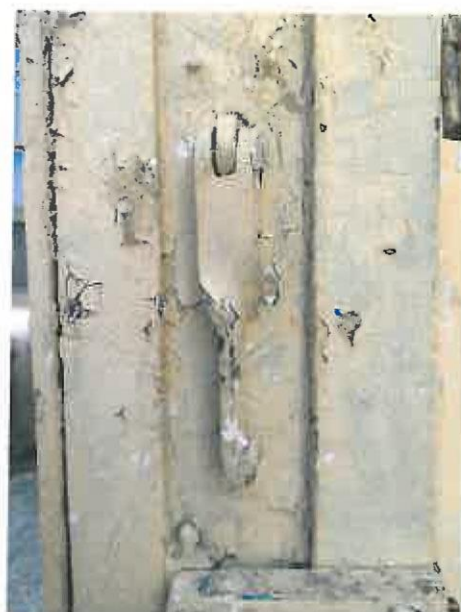
Εικόνες Παράπλευρης εισόδου. Επιφανειακές επικαθίσεις και κρακελάρισμα χρώματος
