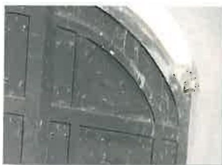
Εικόνες 61, 62. Επικαθίσεις χρώματος και κονιαμάτων
