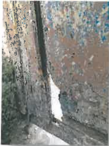
Εικόνες παράπλευρης εισόδου, απώλεια και οξειδώσεις.
