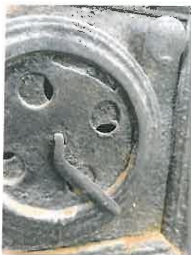
Εικόνες 129, 130. Λεπτομέρεια κατασκευής. Εκδορά και απομάκρυνση χρωματικής επικάλυψης.
