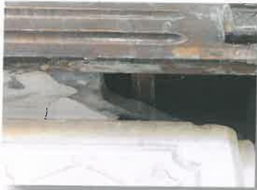
εικόνες 125, 126. Θραύσεις στο μαρμάρινο οριζόντιο τμήμα
