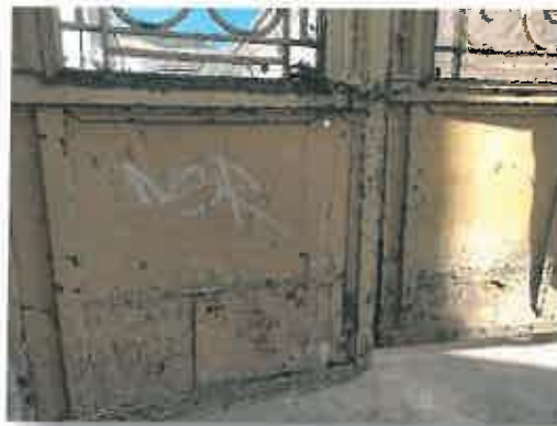
Εικόνες παράπλευρης εισόδου, απώλεια και οξειδώσεις.
