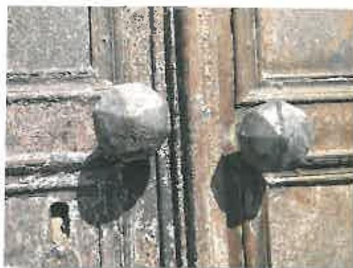
Εικόνες 67, 68. Κρακελάρισμα και απώλεια των χρώματος.
