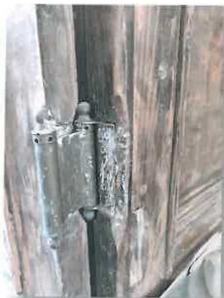
Εικόνες 25, 26. Επικαθίσεις χρωμάτων και αιωρούμενων σωματιδίων
