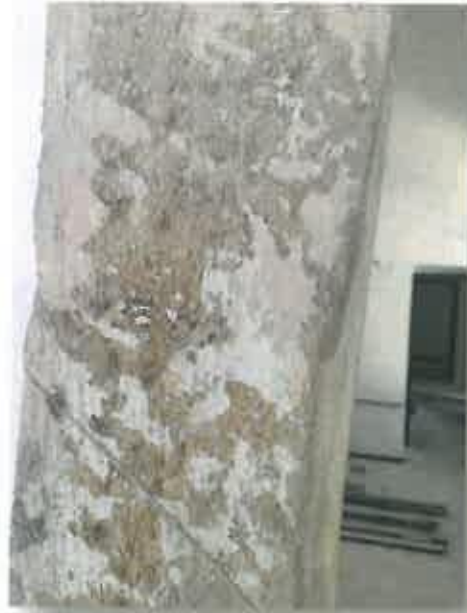
Εικόνα 110. Απώλειες χρωμάτων
