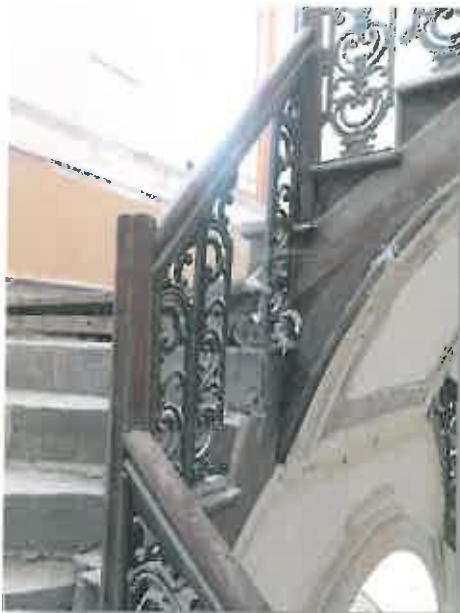
Εικόνες 17-18. Θραύση στο ρίχτι.
