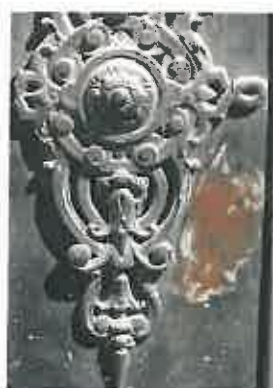
Εικόνες 61, 62. Επικαθίσεις χρώματος και κονιαμάτων
