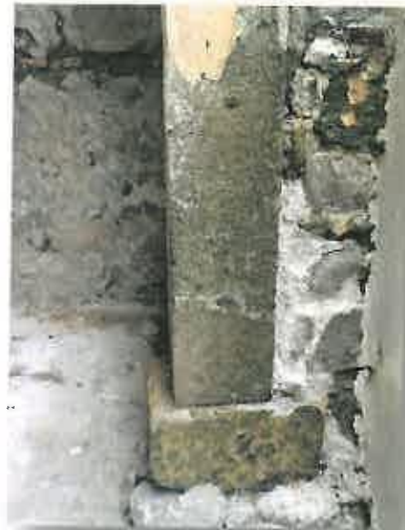
Εικόνα 106. βιολογικές επικαθίσεις
