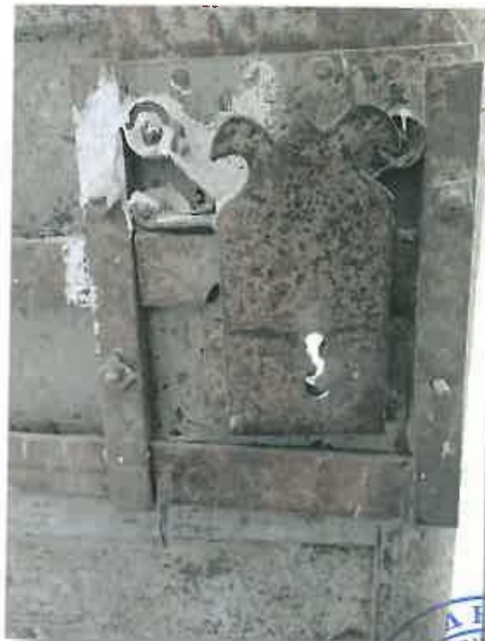
Εικόνα 75. Επιφανειακές επικαθίσεις.
