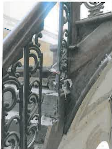
Εικόνες 87, 88, 89, 90. Επιφανειακές επικαθίσεις, χρωματικές απώλειες και θραύση κιγκλιδώματος.
