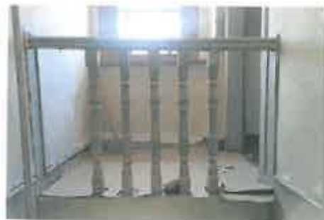
Εικόνα 44. Το κιγκλίδωμα του 1 ου -2 ου ορόφου
