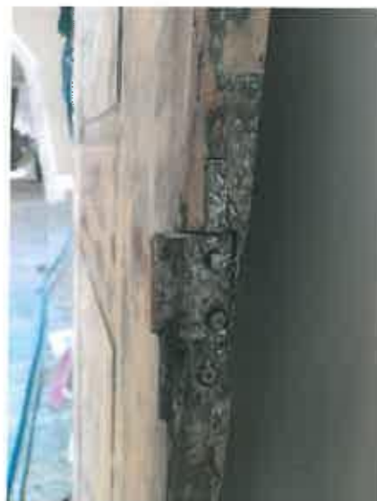
Εικόνα 33. Τμήμα μεντεσέ 1 ου ορόφου.
