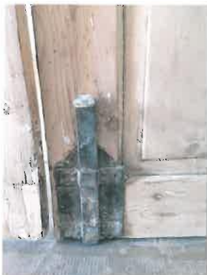
Εικόνες 34, 35. Σύρτης συγκράτησης των θυρών και μεντεσές 2 ου ορόφου.
