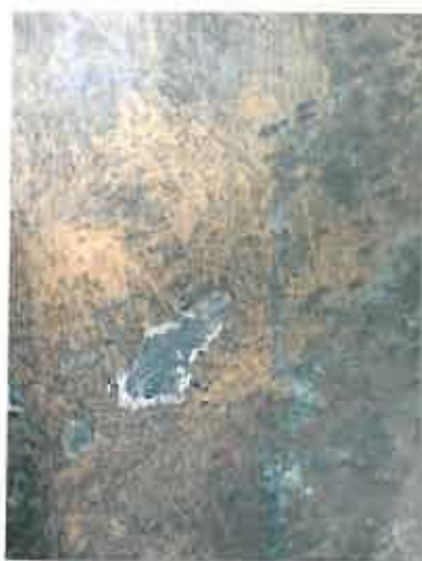
Εικόνες 129, 130. Λεπτομέρεια κατασκευής. Εκδορά και απομάκρυνση χρωματικής επικάλυψης.
