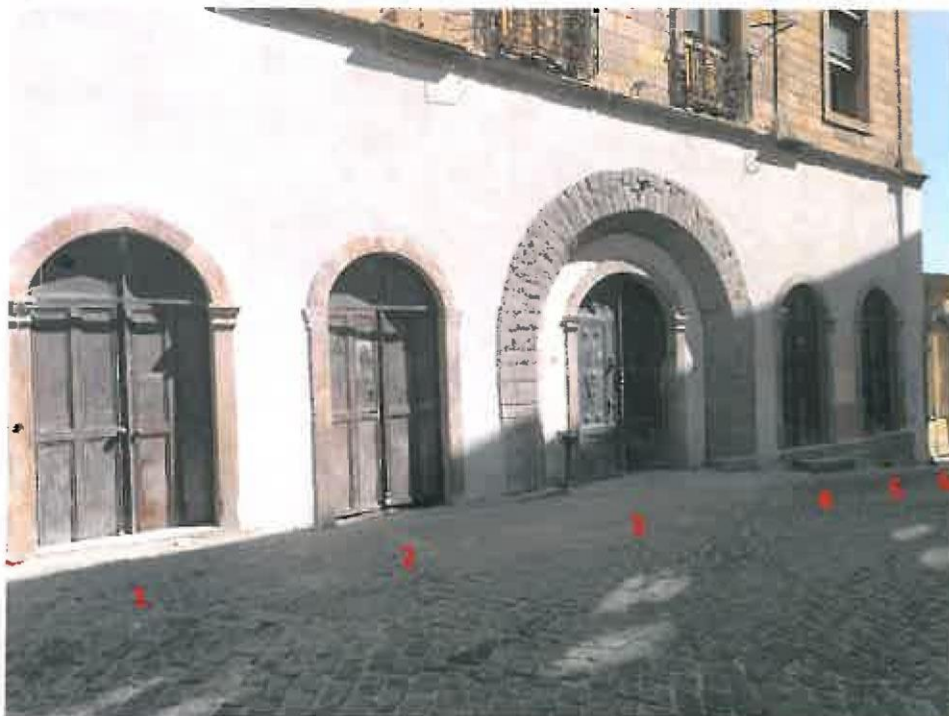
Εικόνα 49. Οι θύρες της όψης του κτηρίου
