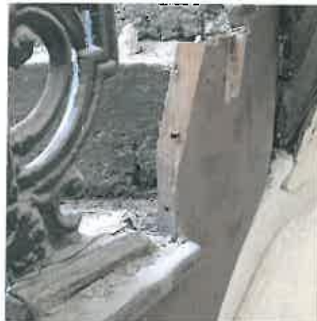
Εικόνες 17-18. Θραύση στο ρίχτι.
