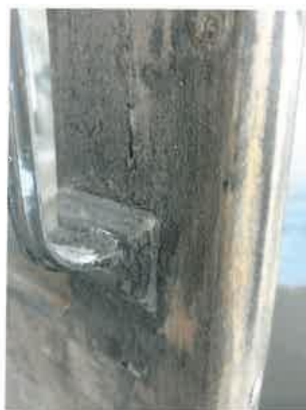
Εικόνες 25, 26. Επικαθίσεις χρωμάτων και αιωρούμενων σωματιδίων
