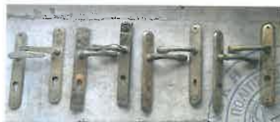
Εικόνες 91, 92, 93, 94, 95. Η κατάσταση διατήρησης των μεταλλικών εξαρτημάτων των ξύλινων θυρών.
