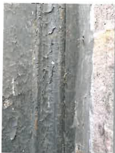
Εικόνες 67, 68. Κρακελάρισμα και απώλεια των χρώματος.
