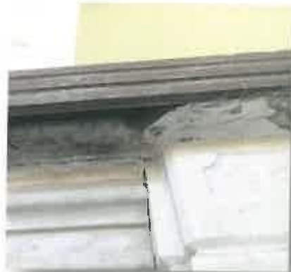
εικόνες 125, 126. Θραύσεις στο μαρμάρινο οριζόντιο τμήμα
