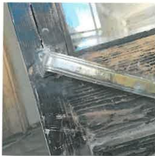
Εικόνες 23, 24. Απομάκρυνση του βερνικιού και εκδορές στην επιφάνεια από την χρήση λειαντικών φύλλων.
