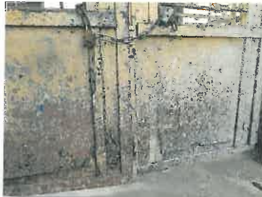
Εικόνες παράπλευρης εισόδου, απώλεια και οξειδώσεις.
