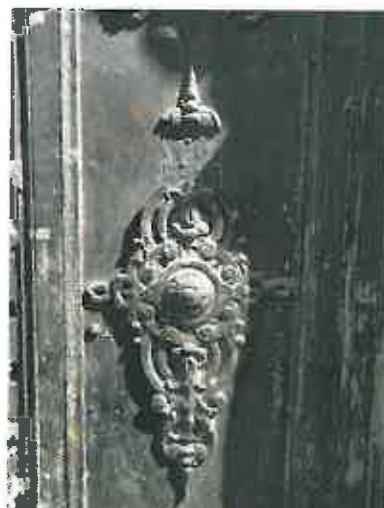
Εικόνες 63, 64. Επιφανειακή οξείδωση
