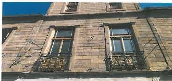
Εικόνες 96, 97. Λίθινη επένδυση περιθυρώματος και πρόσοψης του κτηρίου
