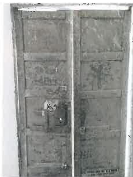
Εικόνα 76, 77. Η πίσω πλευρά της θύρας η οποία εμφανίζει διάβρωση και απώλεια των χρωματικών επικαλύψεων.
