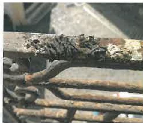
Εικόνες 83, 84, 85, 86. Απώλεια και κρακελάρισμα χρωματικής επικάλυψης, οξειδώσεις και επικαθίσεις περιπτώματων.
