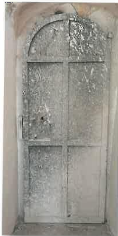
Εικόνες 80, 81, 82. Επιφανειακές επικαθίσεις και οξειδώσεις
