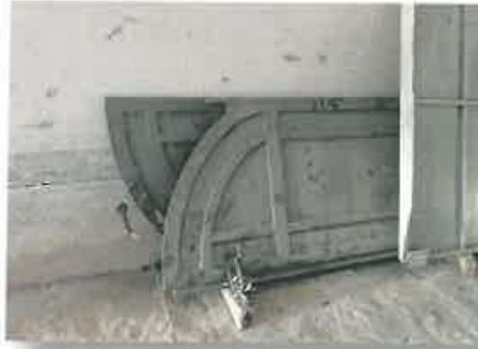
Εικόνα 52. Η θύρα που οδηγεί στην πίσω αυλή.
