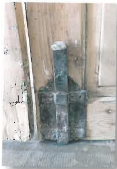
Εικόνες 91, 92, 93, 94, 95. Η κατάσταση διατήρησης των μεταλλικών εξαρτημάτων των ξύλινων θυρών.
