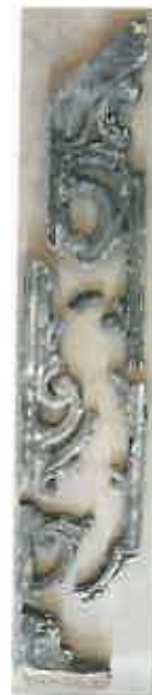
Εικόνες 87, 88, 89, 90. Επιφανειακές επικαθίσεις, χρωματικές απώλειες και θραύση κιγκλιδώματος.
