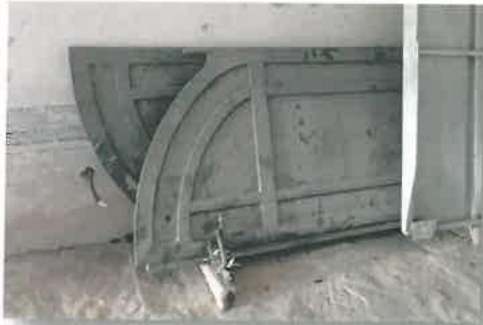
Εικόνα 74. Η δίφυλλη θύρα που οδηγεί στον πίσω αύλειο χώρο.
