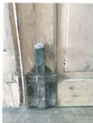
Εικόνες 58, 59. Μεντεσές και σύρτης συγκράτησης θυρών.
