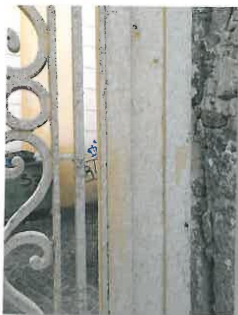
Εικόνες Παράπλευρης εισόδου. Επιφανειακές επικαθίσεις και κρακελάρισμα χρώματος
