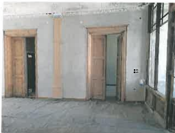
Εικόνα 30. Θύρες του πρώτου ορόφου μετά τον καθαρισμό.
