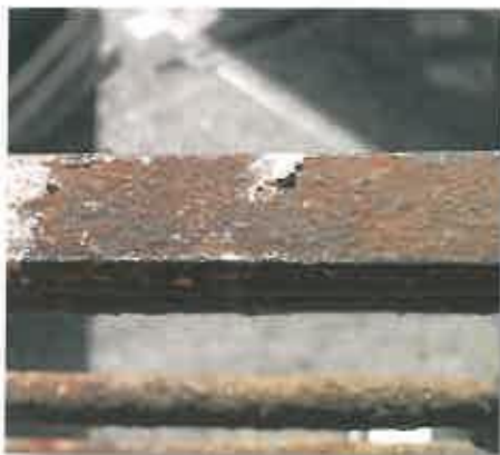
Εικόνες 83, 84, 85, 86. Απώλεια και κρακελάρισμα χρωματικής επικάλυψης, οξειδώσεις και επικαθίσεις περιπτώματων.
