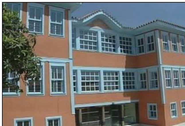
Εικόνα: Το Κονάκι του Μουζαφέρ Μπέη μετά από την αποκατάσταση
