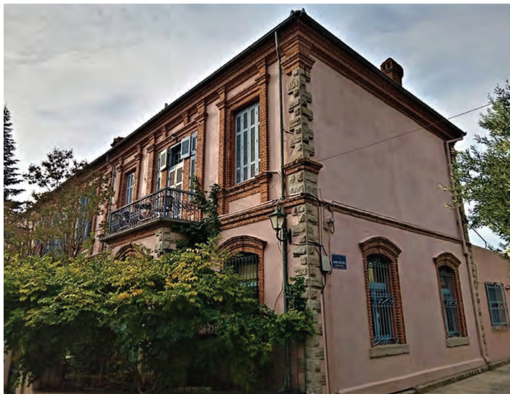
Άποψη της δεξιάς γωνιακής οικίας με τον αριθμό 31 ■ View of the right corner residence, at number 31.
