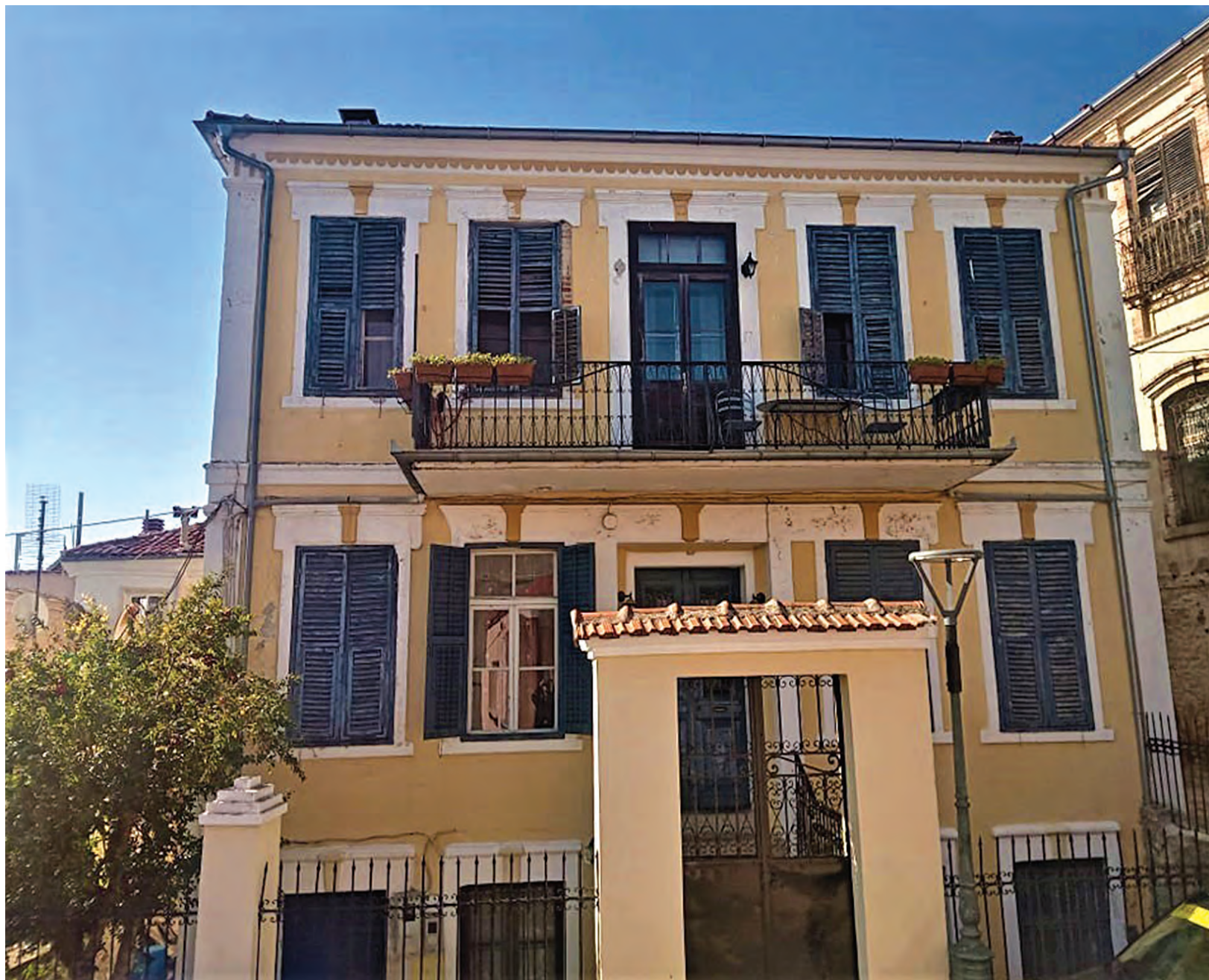
Η νεοκλασική πρόσοψη του οικοδομήματος. Υψικόρμη κιγκλιδωματική εξώθυρα και περίφραξη με ενδιάμεσους πεσσούς. The neoclassical facade of the building. Lofty railed front door and fence with intervening columns.
