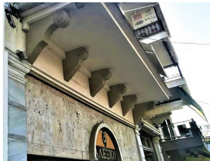
Η επιμελημένη προεκτεταμένη μαρκίζα-στέγαστρο και τα αδρά εντυπωσιακά υποστηρικτικά φουρούσια, σε στυλ Art Deco, στη σημερινή μορφή του κτίσματος.
